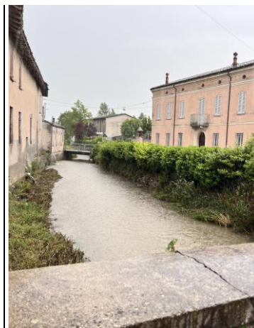
Fig. 21. Vista sullo Scolo Fuga
