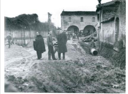
Fig. 5. Lavori di tombinatura di Piazza Risorgimento. Vignoli 2007.
