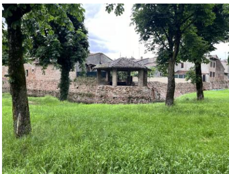
Fig. 9. Mura e torre circolare d'angolo (torre sud-est).
