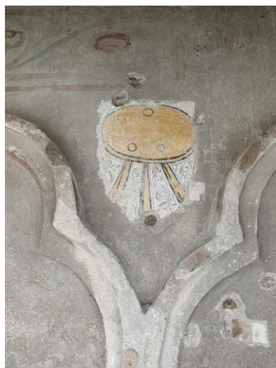
Fig. 14. Decorazione nel sottogronda del rivellino e tracce di armi da fuoco. Stemma di Redondesco scoperto nei ultimi lavori di restauro del 2023.
