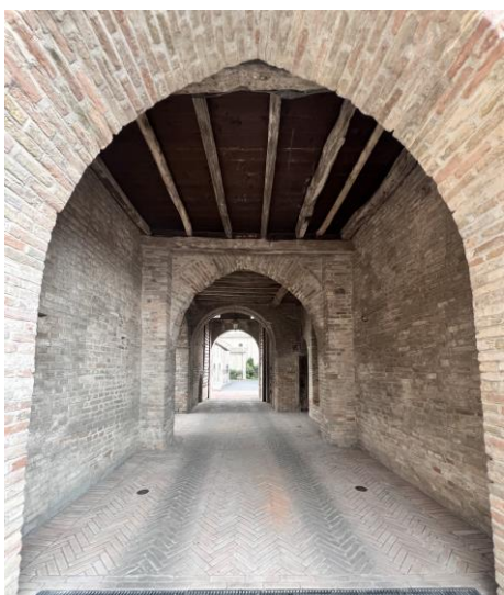
Fig. 24. Arco a sesto acuto alla base della torre, verso il borgo fortificato.
