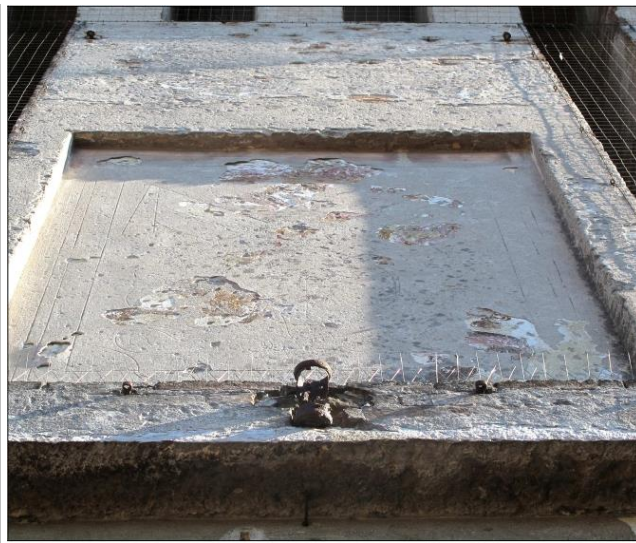
Fig. 8. Specchiatura prima dello strappo del substrato di intonaco con le incisioni della raffigurazione novecentesca.
