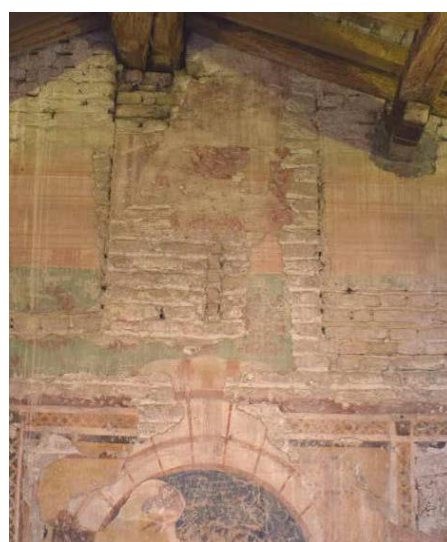
Fig. 26. Muratura con giunti stilati tra i mattoni. Fronte nord della torre visibile all'ultimo piano dell'ex alloggio del comandante.
