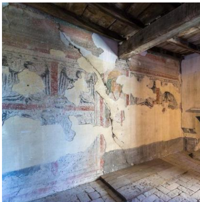
Fig. 21. Sala al secondo piano, c.d. dell'Angelo, muro sud.
