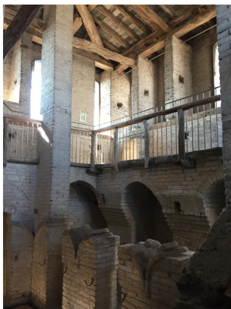
Fig. 17. Interno del rivellino.
