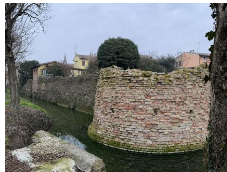
Fig. 11. Mura e torre circolare d'angolo (torre sud-ovest).
